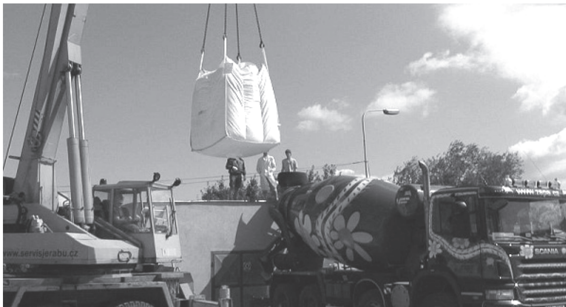
Obr. 2. Jeřáb plní škrobem domíchávač betonu.
