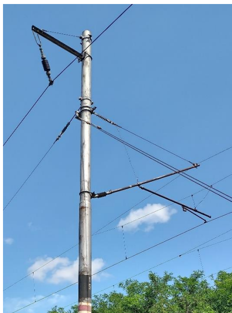
Obr. 4. Izolátory na stožáru nesoucím trolej. Samotná trolej je vodivě propojena s nosným lanem i tzv. výložníkem (trubková konstrukce, ke které jsou nosné lano a trolej upevněny). Výložník je k nosnému stožáru upevněn pomocí izolátorů. Na vršku stožáru je na izolátoru zavěšeno přidavné vedení.
