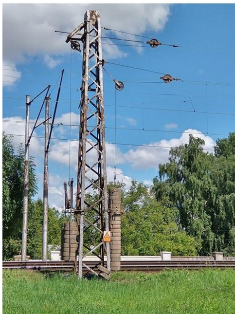
Obr. 15. Napínání troleje pomocí kladek nebo navijáku. V případě navijáku je trolej (resp. nosné lano) navinuta na menším kole navijáku, lano nesoucí závaží na větším kole. Větší kolo je navíc opatřeno zuby, které zapadnou do západky v případě, že by došlo k náhlému odlehčení lana (např. při prasknutí). V takovém případě je zabráněno pádu závaží.
