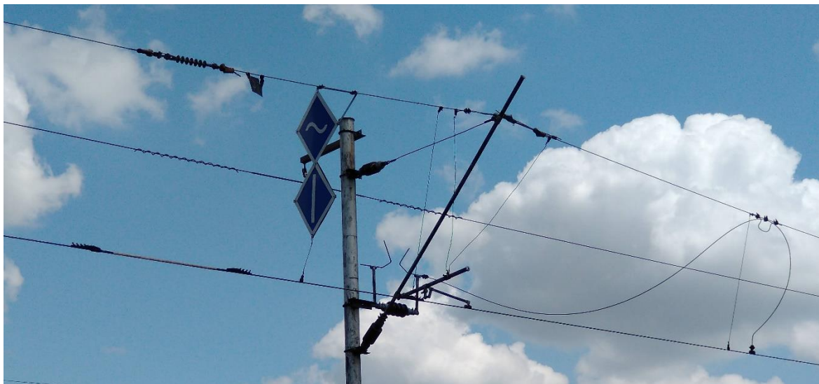
Obr. 14. Styk stejnosměrné a střídavé soustavy ve stanici Kutná Hora hl. n. Horní obr.:
