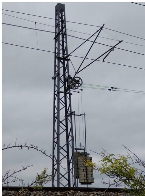
Obr. 15. Napínání troleje pomocí kladek nebo navijáku. V případě navijáku je trolej (resp. nosné lano) navinuta na menším kole navijáku, lano nesoucí závaží na větším kole. Větší kolo je navíc opatřeno zuby, které zapadnou do západky v případě, že by došlo k náhlému odlehčení lana (např. při prasknutí). V takovém případě je zabráněno pádu závaží.
