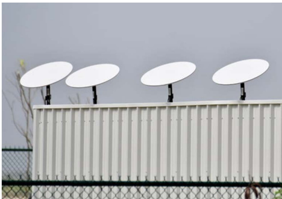
Obr. 6. Pozemní terminál pro příjem ze sítě Starlink [5].
