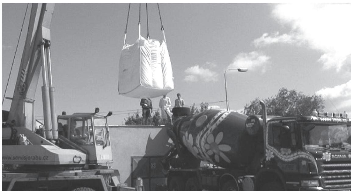
Obr. 2. Jeřáb plní škrobem domíchávač betonu.
