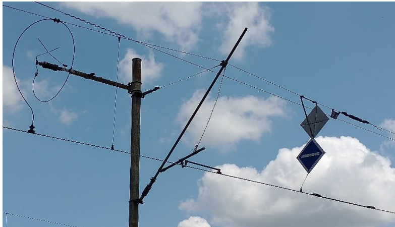
Obr. 13. Schéma styku stejnosměrné a střídavé soustavy (převzato z [4]).
