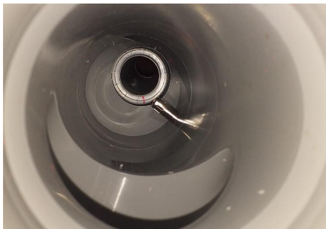
Obrázek 5 - Vnitřek spalovací komory se zasunutým zapalovačem
